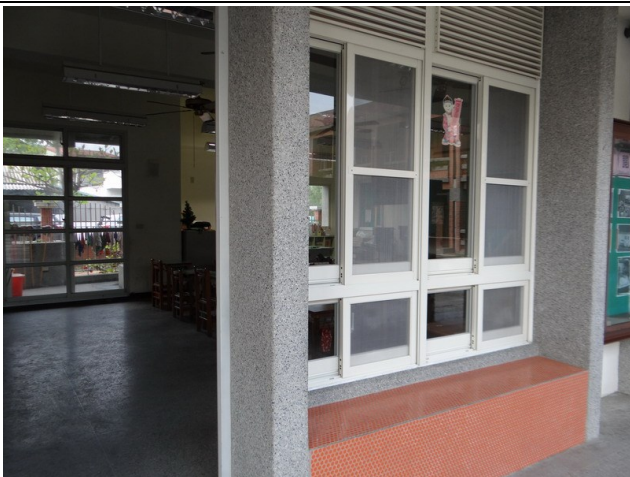
校舍建築採雙面走廊，大窗戶及落地窗透明玻璃設計；採光良好。
