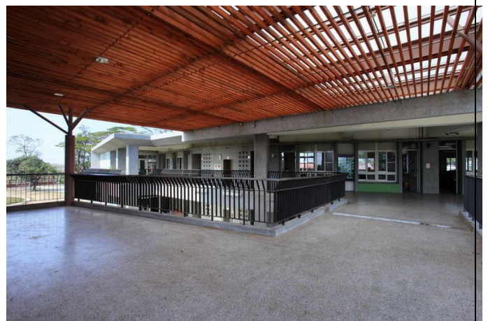
建築量體利用局部透空導入涼爽的西南風散熱。
